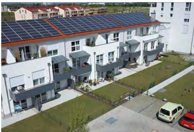
2010 bis 2011 Neubau von 40 Wohneinheiten mit Tiefgarage (EnEV 2009) „Am Himmelweiher West“ (2. BA), Augsburg-Göggingen
