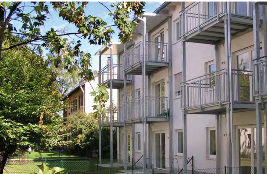
2006 bis 2008 Neubau von 19 Wohneinheiten mit Tiefgarage Betreutes Wohnen „Am Sanderstift“, Augsburg
